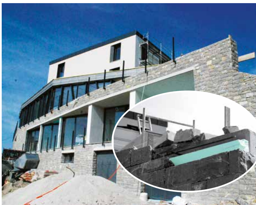
Kamienna elewacja budynku hotelu, ocieplona izolacją nośną FIBRANxps ETICS BT , na którą jest w specjalnym procesie klejony naturalny kamień.
