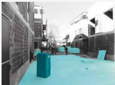
Wykonanie nachylen i zabezpieczenie termiczne płyt (po których się chodzi) w podpiwniczonych jednostkach mieszkalnych (dwa piętra poniżej poziomu terenu).
