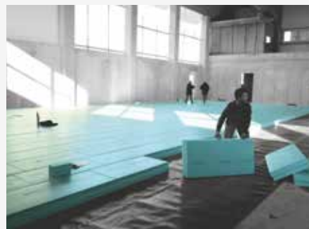
Montaż izolacji termicznej FIBRANxps 500-L pod płytą podłogową obiektu wielofunkcyjnego.
