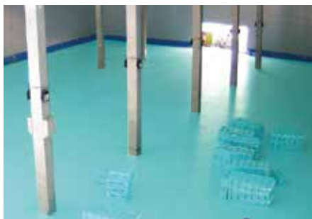
Izolacja termiczna podłogi w chłodni z FIBRANxps 500-L, 700-L.
