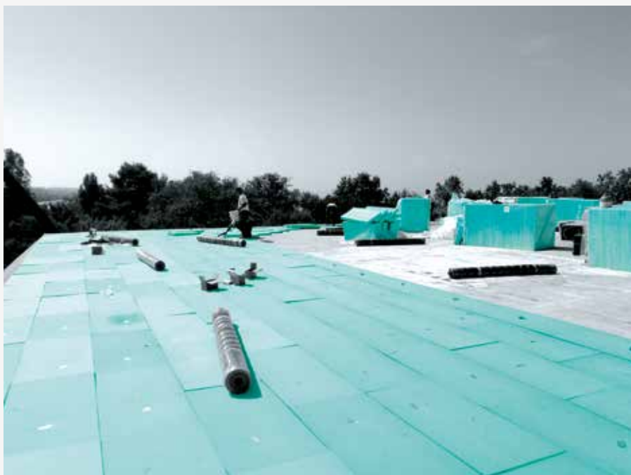
Zwiększanie nachylenia dachu budynku za pomocą FIBRANxps INCLINE i jednocześnie renowacja termiczna dachu płaskiego.
