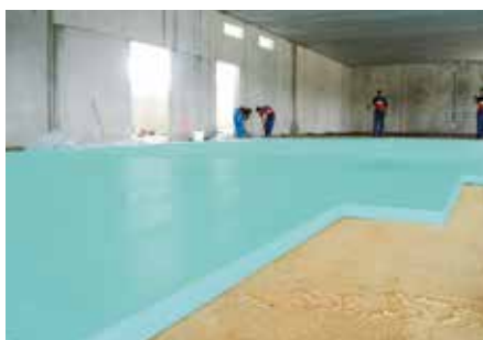
Izolacja termiczna podłogi w magazynie z FIBRANxps 300-L .
