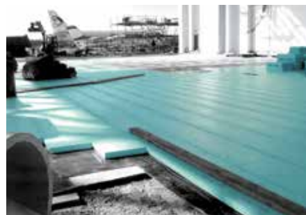
Płyty termoizolacyjne ze spadkiem FIBRANxps 700-L.
