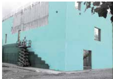
FIBRANxps MAESTRO jako izolacja warstwowa; faza tworzenia zewnętrznej części elewacji z widocznym białym betonem.
