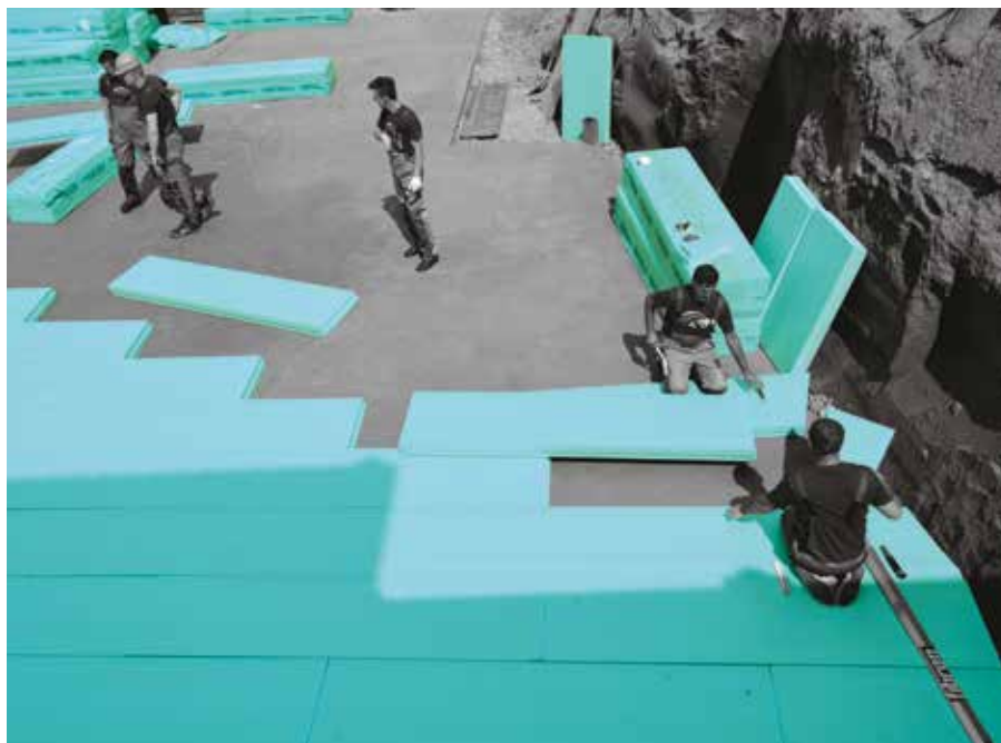
Montaż izolacji termicznej FIBRANxps 400-L pod fundamentami budynków niskoenergetycznych.
