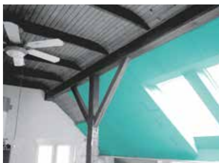
Wykonanie wewnętrznej izolacji termicznej z FIBRANxps ETICS , którą zabezpieczymy cienkowarstwową elewacją i cienką warstwą nakładanej farby.
