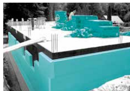
Solidna, praktycznie niechłonna izolacja FIBRANxps 300-L jest mechaniczną ochroną hydroizolacji i stałą ochroną termiczną podziemnej części obiektu także w przypadku wysokiej wody gruntowej.
